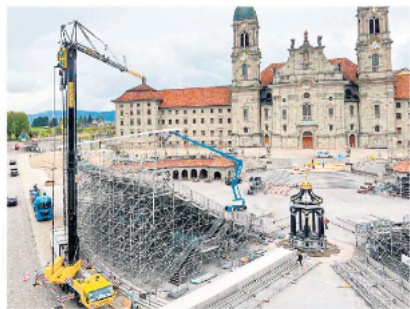
Die Montage wurde am Donnerstag begonnen.
