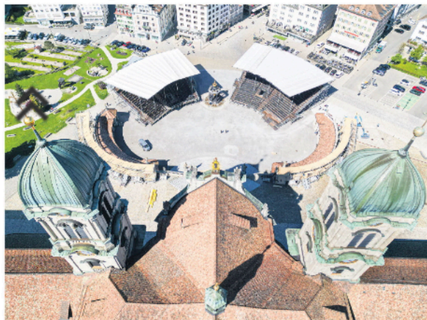
Die Tribüne auf dem Klosterplatz ist ein temporäres Bauwerk aus Holz. Es soll die noch fehlende Tribüne des Klosterplatzes ersetzen. Foto: L. Kna. Bildbearbeitung
